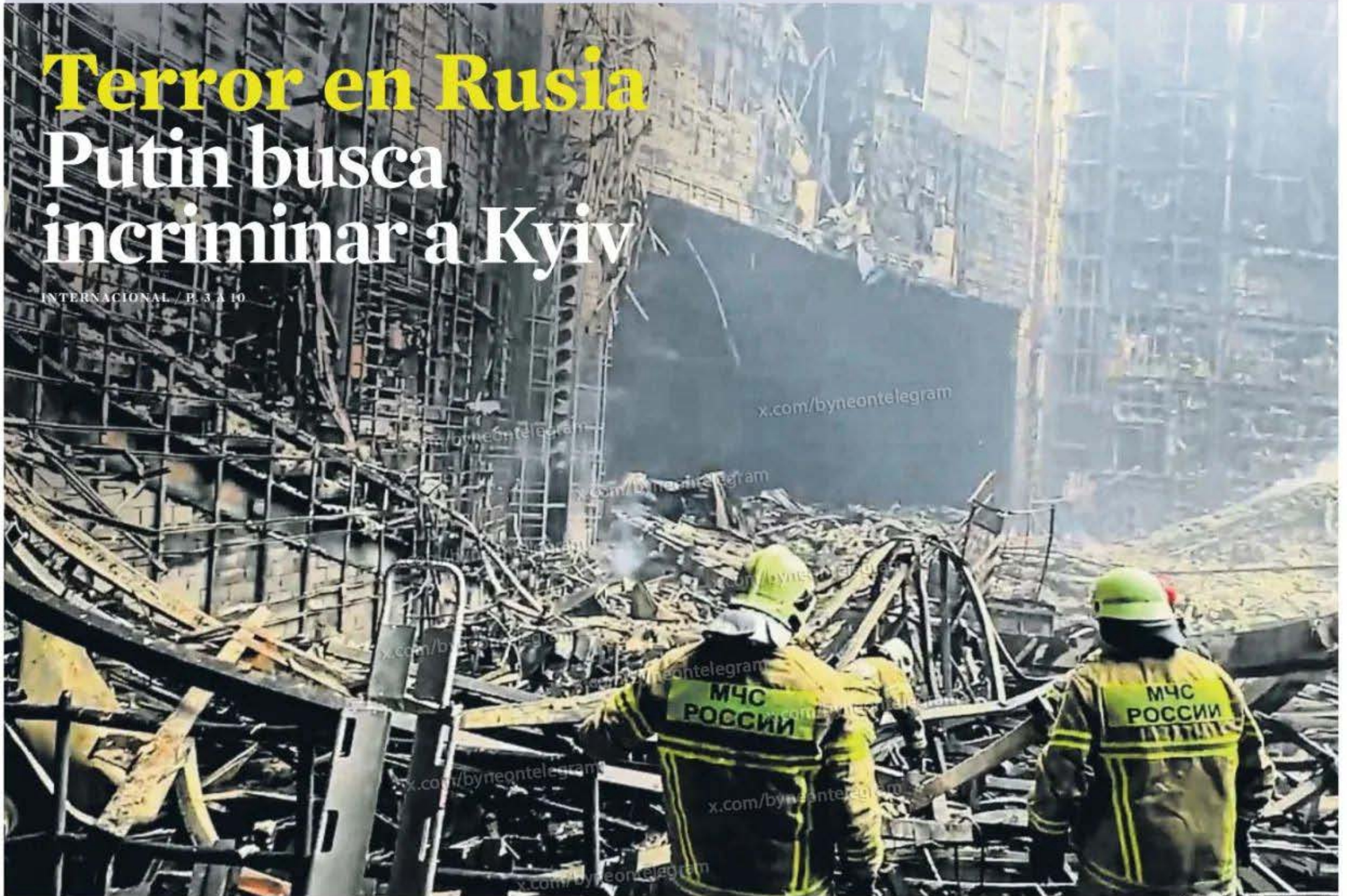
Los bomberos inspeccionan los restos del destruido Crocus City Hall de Krasnogorsk, en la periferia de Moscú, incendiado por los terroristas
